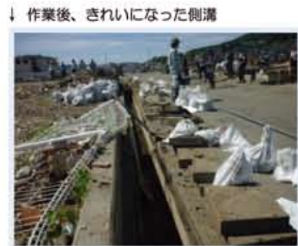
↑ 側溝の泥掻き作業の様子 (井上は写真左) ①溝の蓋を外す→②スコップで泥を掻き出す→③土のう袋につめる→④蓋を戻す。
