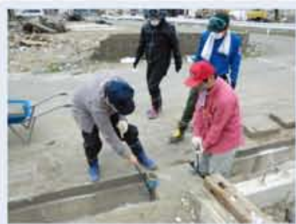
↑ 側溝の泥掻き作業の様子 (井上は写真左) ①溝の蓋を外す→②スコップで泥を掻き出す→③土のう袋につめる→④蓋を戻す。
