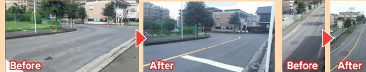
丸山台に抜けるクランク道路では、空港リムジンバスなども通り交通量も多いため、オレンジの中央線が薄くなっていました。車線のハミ出しによる事故を防ぐため中央線の引き直しを行いました。
