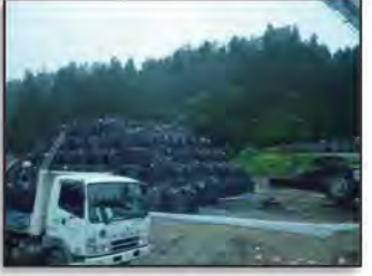
除染作業を視察 中間貯蔵施設の建設が進まず写真のような仮置き場の確保も困難な状況。進め除染作業の実態を垣間見ました。
