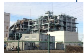
臭気発生箇所となった松ノ木島の汚泥処理施設
