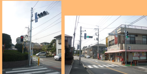
通学路への信号機を新設(ドラゴンマンション 付近)・移設(柳屋商店付近)しました。
