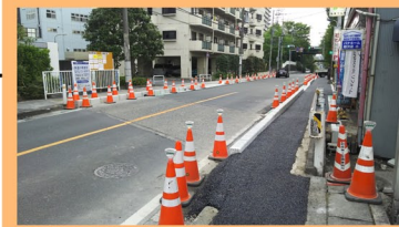
段差をなくす工事が 成増方面へ伸びていきます。
