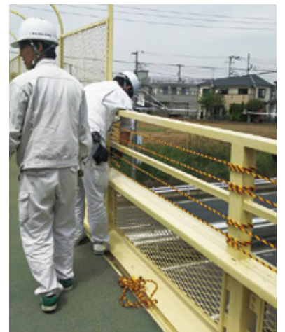
(東輝橋の緊急対策の様子)
