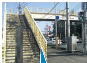
広沢原歩道橋(国道254号)
