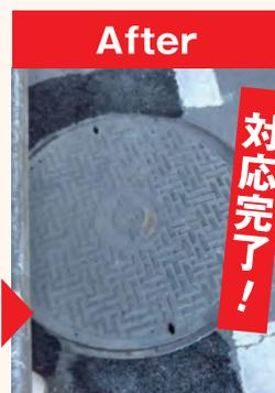
常温合材にて貼り付け工事を実施し、段差解消
